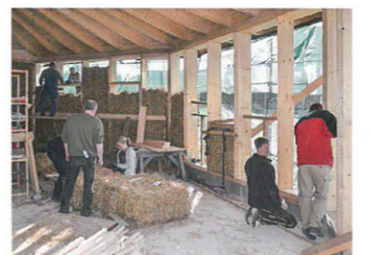
Beim Bau des Strohballenhauses konnte durch die Arbeiten der Dorfbewohner eine Muskelhypothek von 50.000 Euro eingerechnet werden Foto: Henning Austmann
