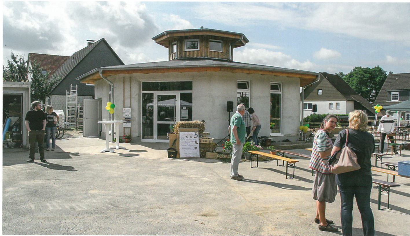
Nahversorgung mit Gemeinschaftsfaktor: Der achteckige Laden steht mitten im Dorf. Fotos: Susanne Küppers/ HauptwegNebenwege.de (o.); Henning Austmann (u.)
